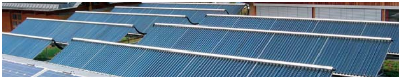
▼ Bild 4: Rückführungsrohre im Sammelkasten sparen Hunderte Meter Rohr
