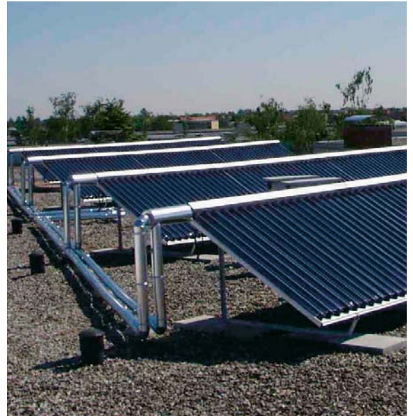
▲ Bild 3: Keine „Tichelmann-Verrohrung“ und kein hydraulischer Abgleich
