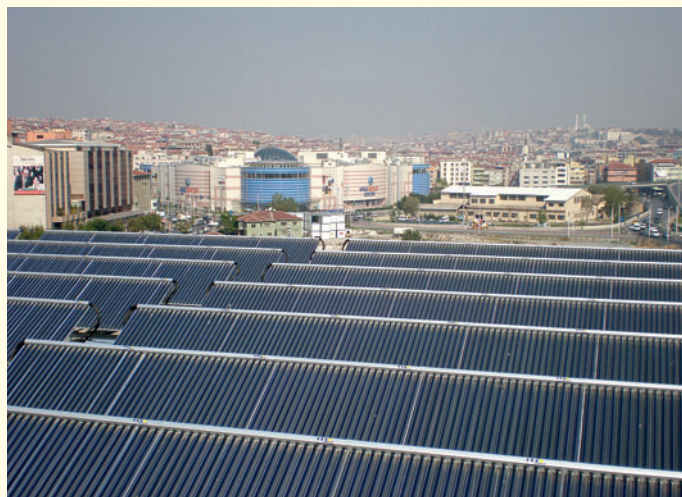
Abb. 1 · Solaranlagen für Heizung im Winter und Kühlung im Sommer in Esslingen (links) und Istanbul (rechts) mit nur ca. 10 Litern Speicher pro Quadratmeter Kollektorfläche und weit über 500 kWh pro Quadratmeter Systemertrag (2011).
