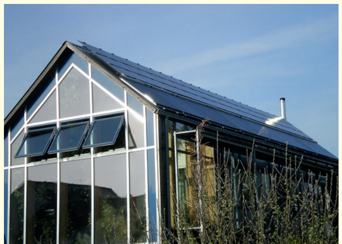
Abb. 2 · Zwei XL-Solarhäuser in Passivbauweise mit ca. 30 bzw. 80 Litern Kombispeicherkapazität pro Quadratmeter Kollektorfläche und mehr als 50 Prozent solarer Deckung für Warmwasser und Heizung.
