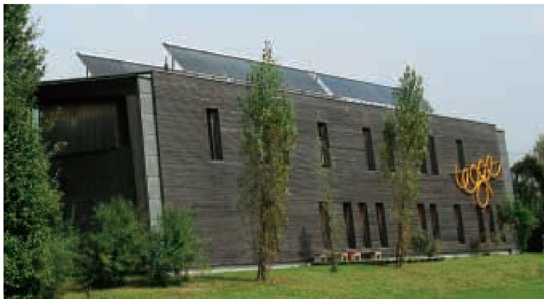
Bild 16 • Paradigma-Röhrenkollektor in Flachdachständerung
